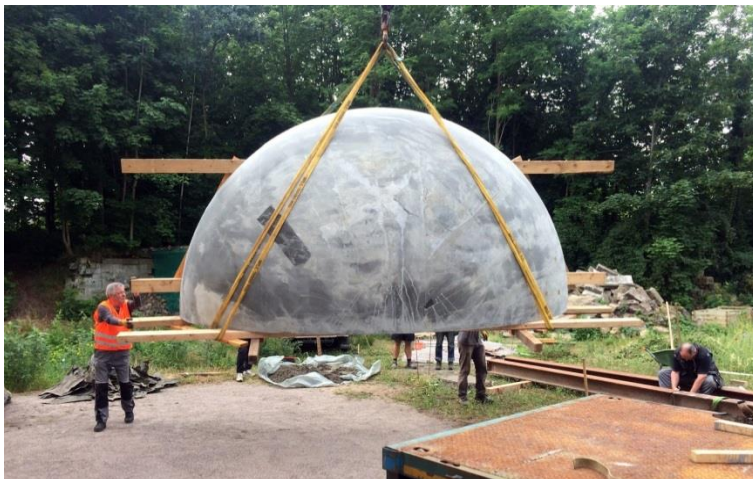
In den letzten Wochen entstand ein Demonstrator aus CFK-bewehrtem Beton, der zum Tag der Architektur in Dresden besichtigt werden konnte. Die Betonschalen haben einen Durchmesser von fünf Metern. FOTO: Gerd Priebe, GPAC – Dresden
