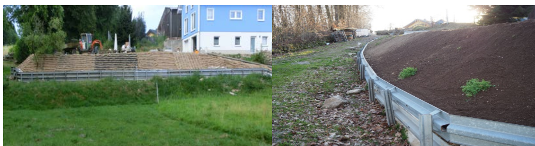
Abbildung 3: Mit Strohsträngen belegter Hang (links) und Muttererde bedeckt (rechts)
