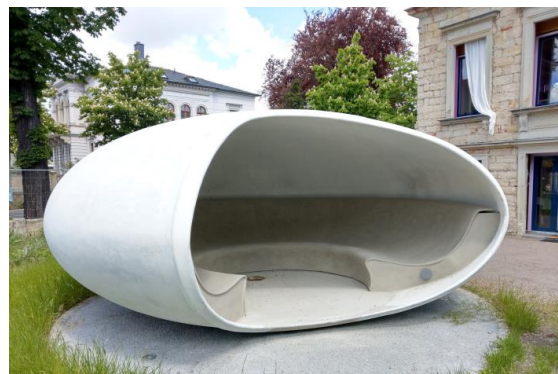
Abb. 3: Pavillon aus textilbewehrtem Beton
