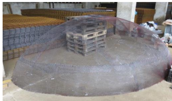
Abb. 2: Filigraner Bewehrungskorb aus Carbonfasern
