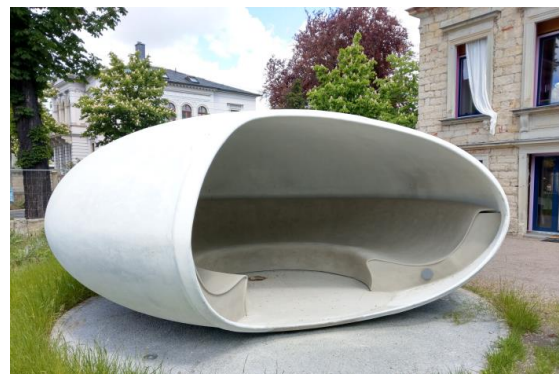
Abb. 3: Pavillon aus textilbewehrtem Beton
